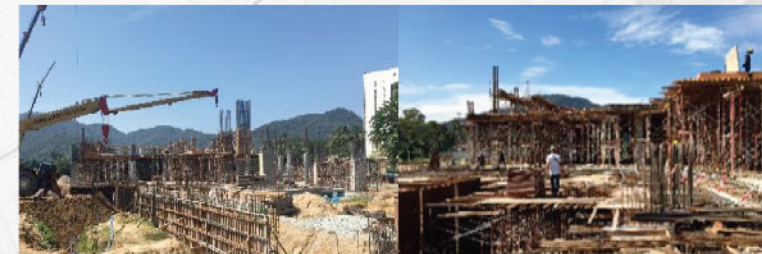
Kerja-kerja pembinaan apartment kos rendah & hotel
