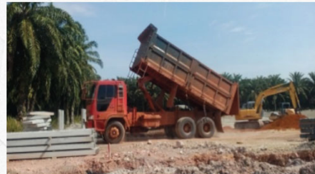
Kerja tanah penyediaan tapak Dewan Serbaguna
