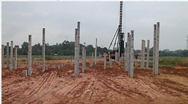
Kerja-kerja cerucuk di tapak Sg. Bakap
