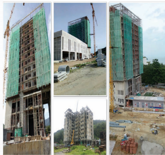
Kemajuan Pembangunan di Tapak Projek Teluk Bahang
